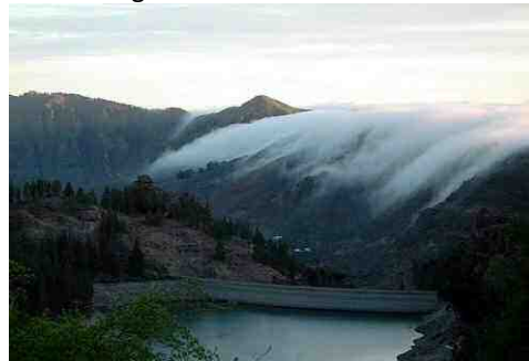
Nuages sur Presa de Los Hornos
